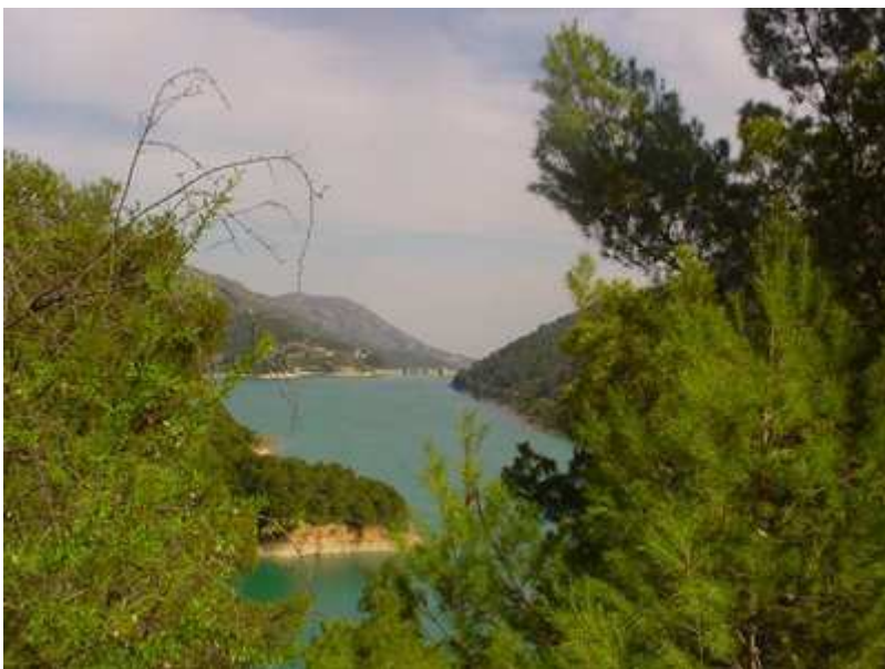
Embalse, por detrás. Se ve la presa al fondo
